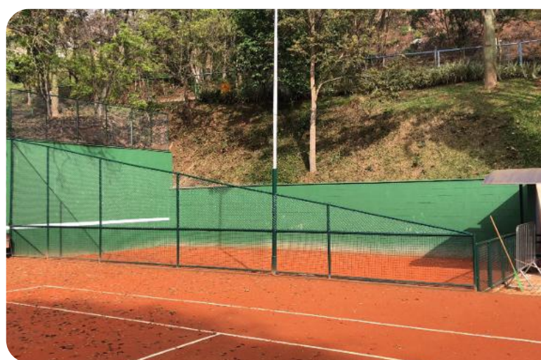
Construção da área de aquecimento na quadra de Tênis
