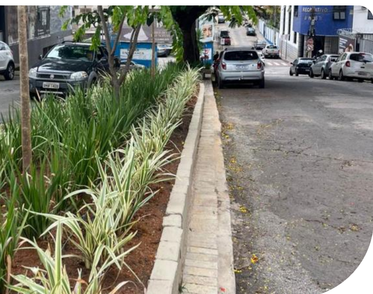
Reforma e paisagismo do canteiro da Avenida Pedro II
