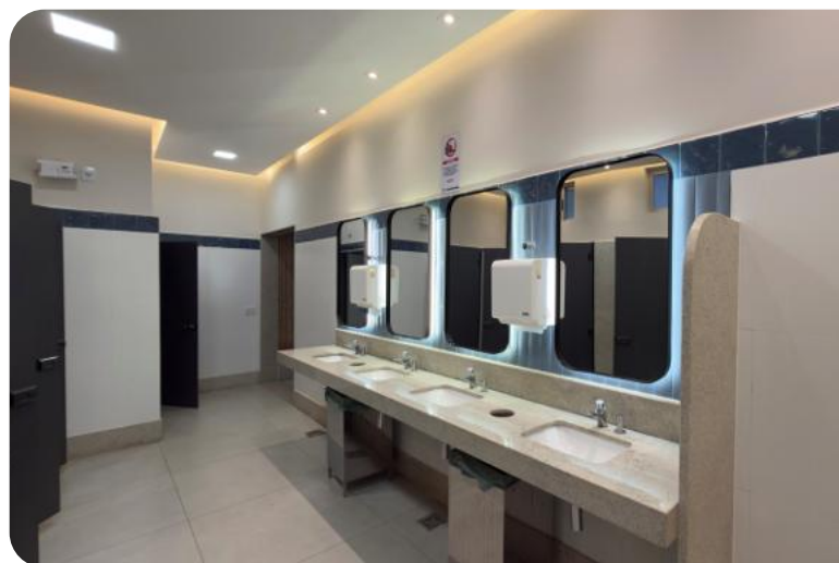
Reforma dos banheiros do Salão de Eventos
