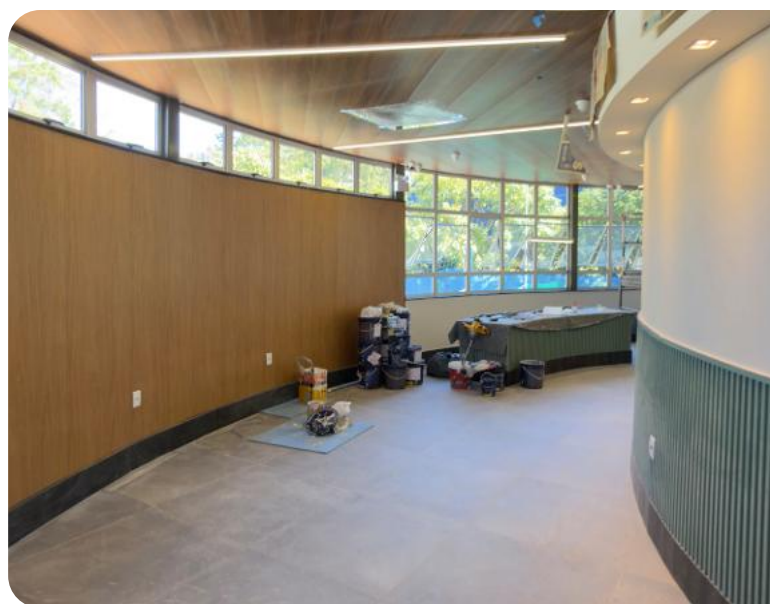
Construção da Gelateria DPII
